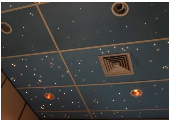
Figure 8 – Detalhe do teto após a aplicação do efeito céu estrelado com fibra ótica
